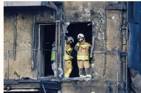
Figura 2. Bomberos inspeccionando el edificio de Valencia
