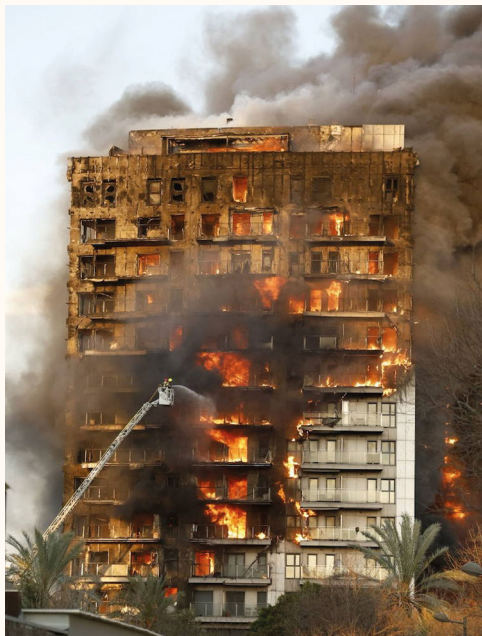
Figura 1. Edificio en el barrio de Campanar de Valencia
