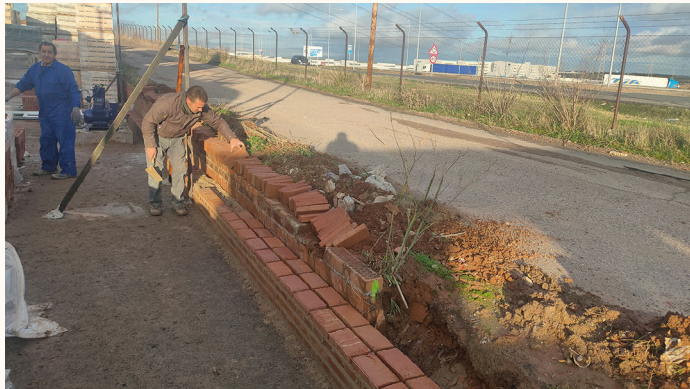
Figura 11. Construcción del demostrador (I).
