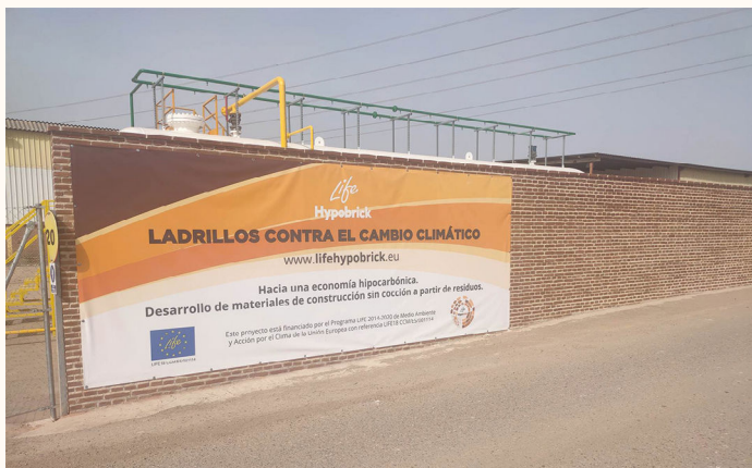
Figura 13. Demostrador del Proyecto LIFE HYPOBRICK construido con ladrillos de bajo impacto ambiental.
