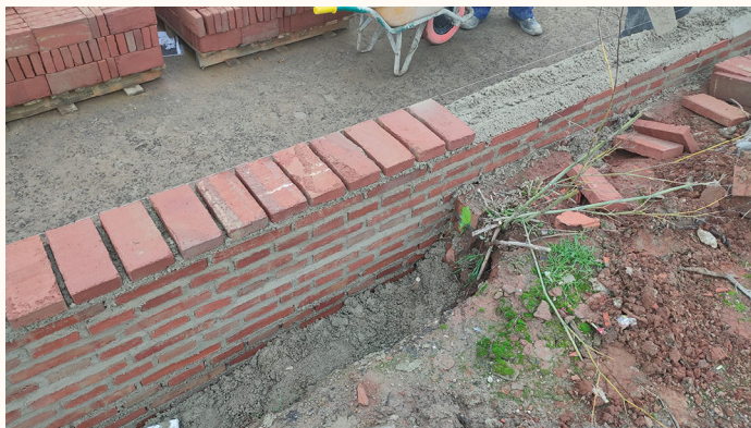
Figura 12. Construcción del demostrador (II).
