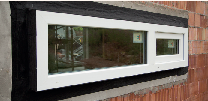
Figura 2. Pasiva Positiva (Toledo) con sistema SATE sobre muro de carga de Termoarcilla rectificada. (Arquitectura: VAND arquitectura, Promotor: Passive House Consultores)
