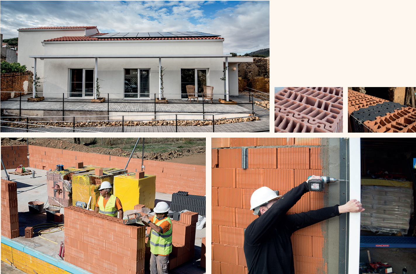
Figura 2. Pasiva Positiva (Toledo) con sistema SATE sobre muro de carga de Termoarcilla rectificada. (Arquitectura: VAND arquitectura, Promotor: Passive House Consultores)
